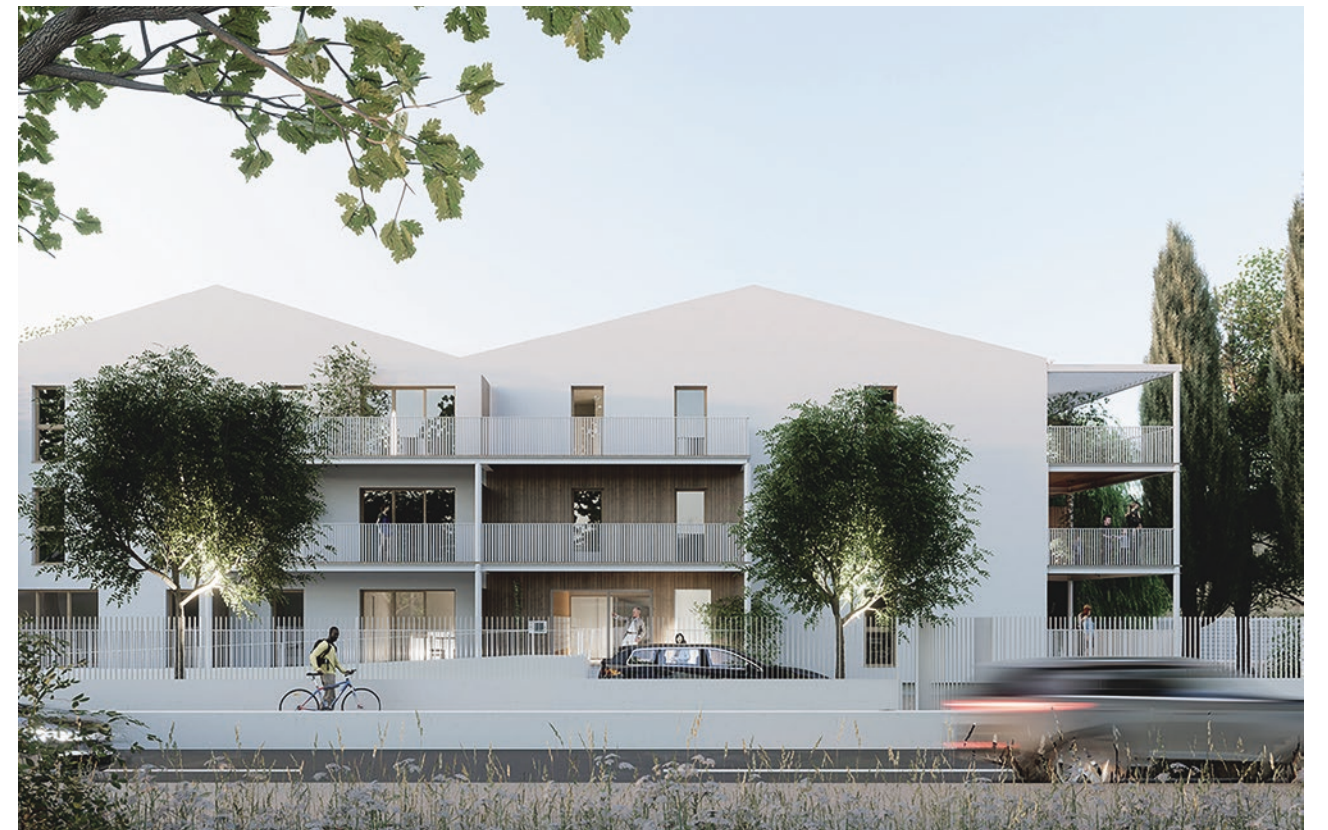
Résidence «Doux Rêves», 46 logements à Morières-lès-Avignon. Livraison prévue début 2025.
