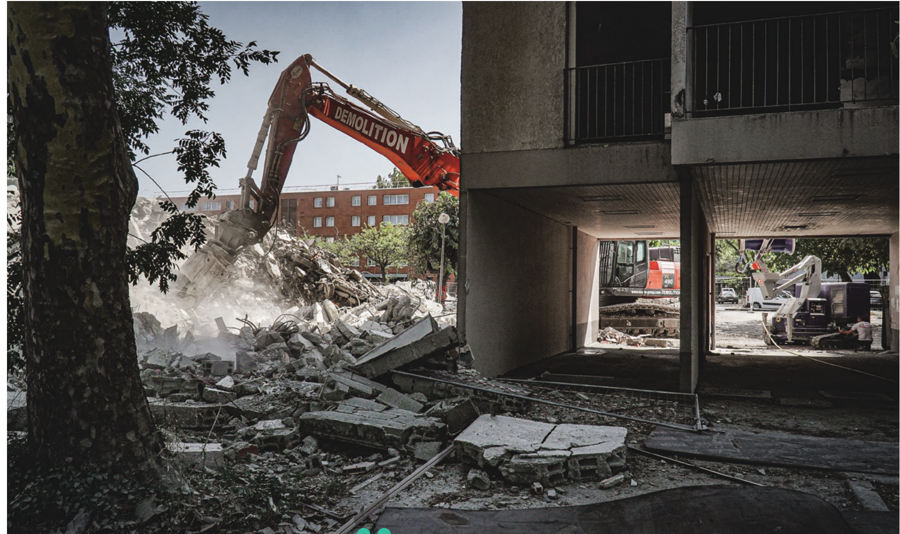
Démolition de 62 logements situés au bâtiment bas de la résidence La Trillade (construit en 1971).
